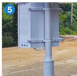
立杆安装，2个卡箍4颗螺丝钉把机箱固定到立杆上
