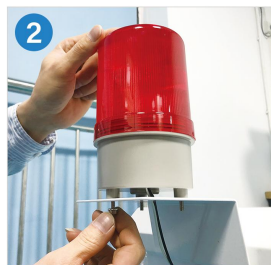
将报警灯安装在托片上
